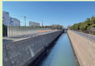
⑦【河川】高瀬川の水門整備
